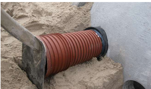
8. Skub tilløbsrøret på plads. Det anbefales at begynde med et kort muffestykke, så indstik kan kontrolleres.
