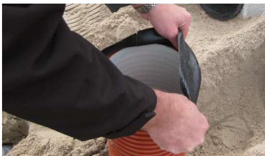
6. Montér justeringsring (JR) på tilløbsrør, hvis skema 1 angiver dette.
