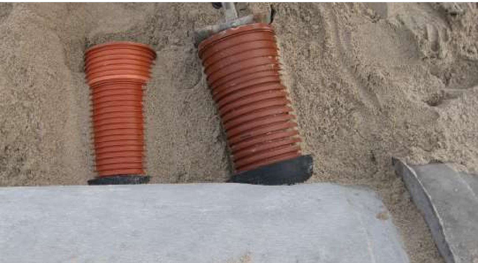
Tilslutning vinkelret på og med svagt medløb.
