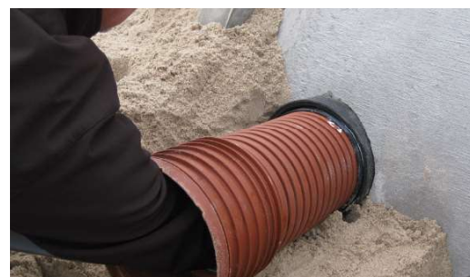
9. Kontrollér at pakning eller tilløbsrør ikke stikker ind i hovedledning eller brønd, samt at tilløbsrøret er korrekt monteret mod pakningens rørstop.
