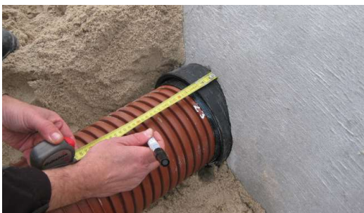
10. Lav en afmærkning på tilløbsrøret (f.eks. 200 mm inde på røret) så du hurtigt kan kontrollere, at tilslutningen ikke er blevet presset ind i hovedledningen ved montagen af de efterfølgende rør.
