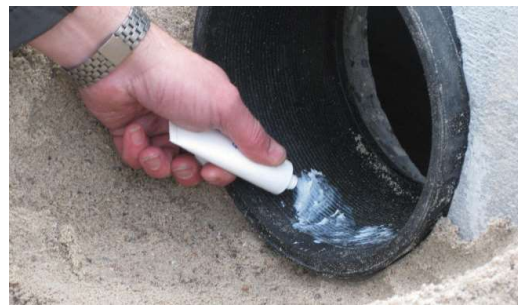
7. Påfør glidemiddel på såvel pakning som tilløbsrør/justeringsring.
