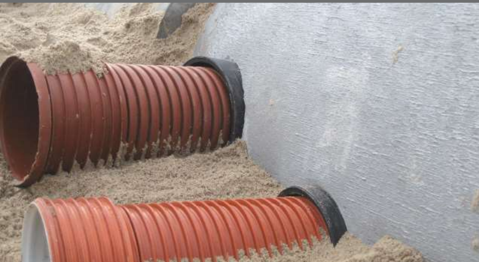
Påboring med hhv. ribberør og korrugeret rør.
