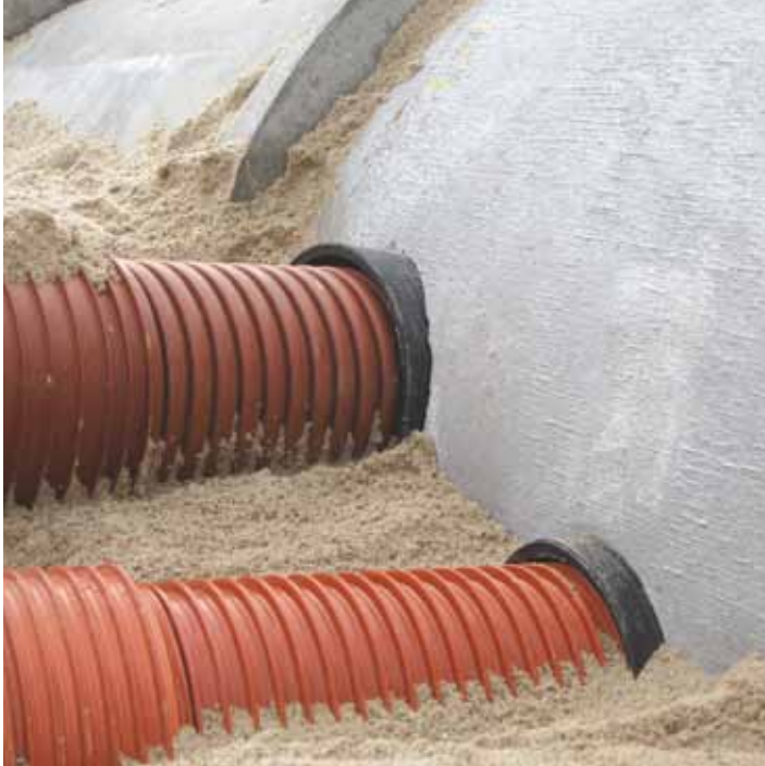
Påboring med hhv. ribberør og korrugeret rør.
