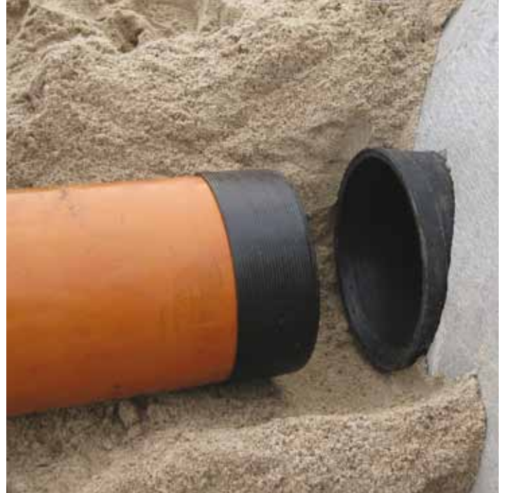
Tilslutning med glat pvc rør.
