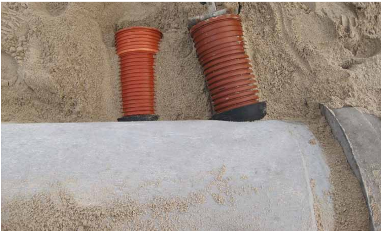
Tilslutning vinkelret på og med svagt medløb.
