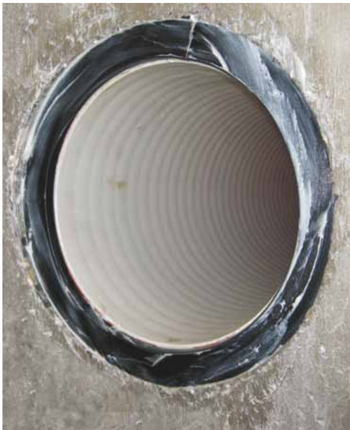
Ingen indragende dele i rør eller brønd.
